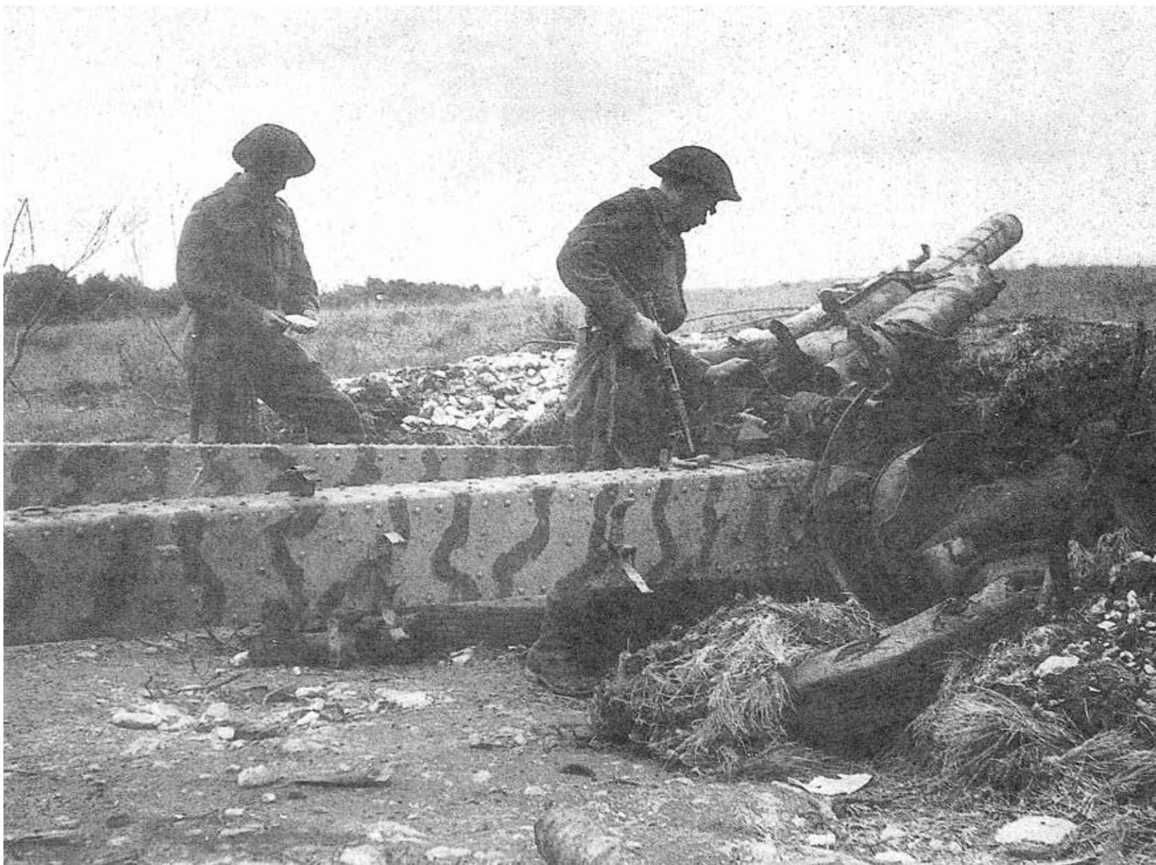
Le reste de la batterie de Moulineaux enlevée par les Chaudières examinées par la 4 ème Cie Canadian Provost Corps H. Devrie & M. Sallens (APC).
